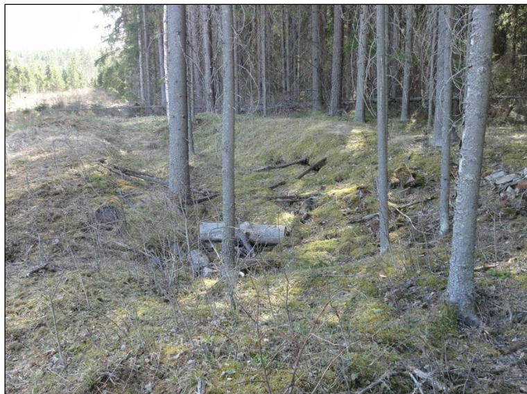
Kuivaamon tai höyrylaitoksen perusta radan varressa (etelään)
